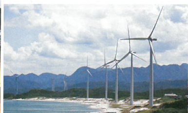
① 風力発電（島根県江津市）風のよくふく場所に風車を設置し、その回転力で発電する。
